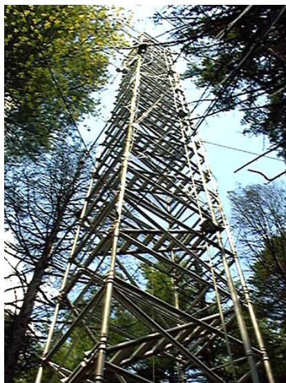
Сл. 17 Кула од метална конструкција за поставување на собирачи над крошните и друга апаратура
